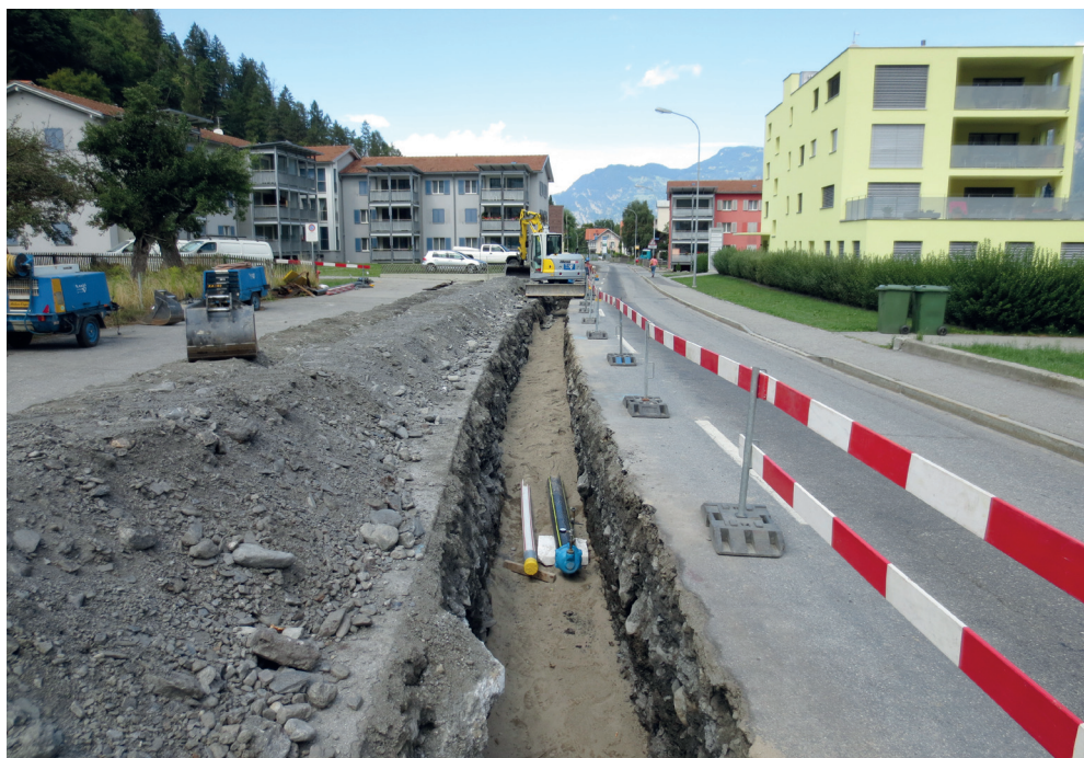
In der Compognastrasse schreiten die Bauarbeiten planmässig voran.
